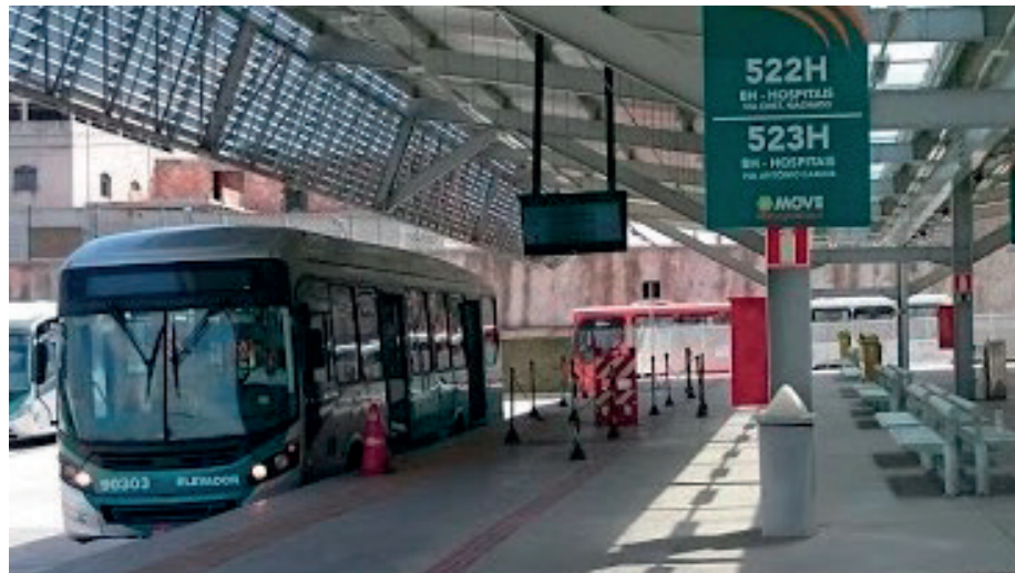
Figura 1.2: Sinalização, pisos táteis, faixas de pedestres em um terminal de ônibus do sistema metropolitano de ônibus de Belo Horizonte-MG.
