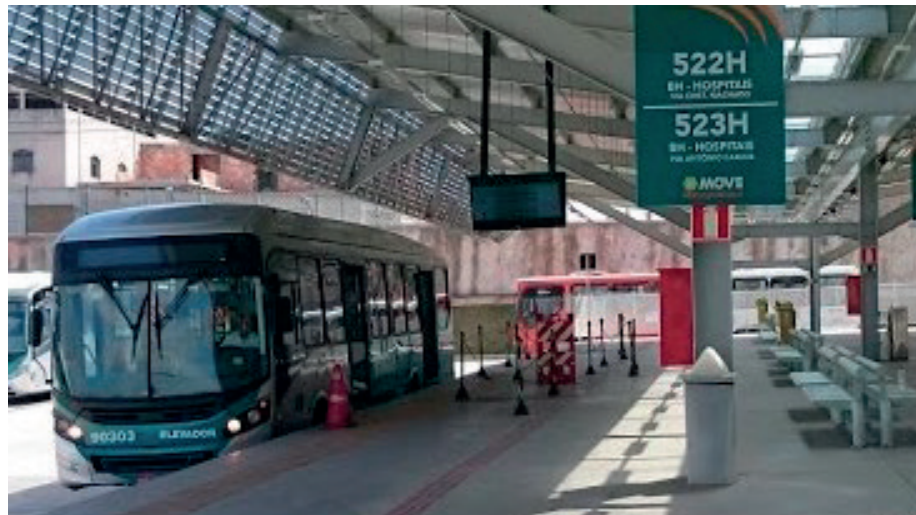
Figura 1.2: Sinalização, pisos táteis, faixas de pedestres em um terminal de ônibus do sistema metropolitano de ônibus de Belo Horizonte-MG.
