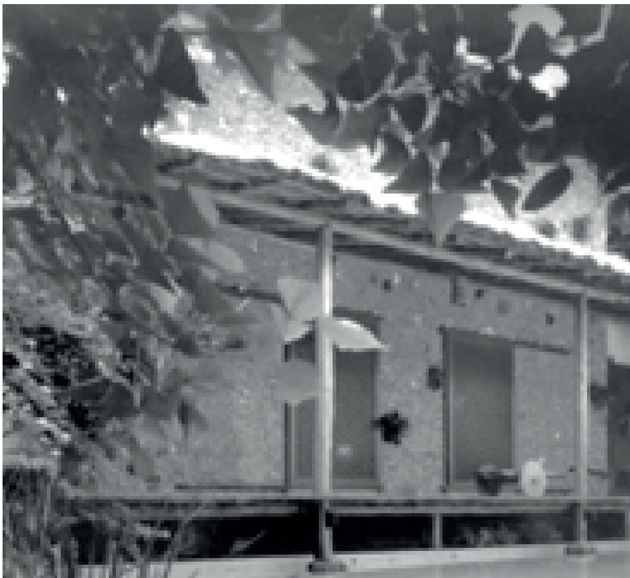
Figura 10: Vista externa da Casa Cirell, de onde se veem as sapatas de apoio dos pilares dentro da piscina.
