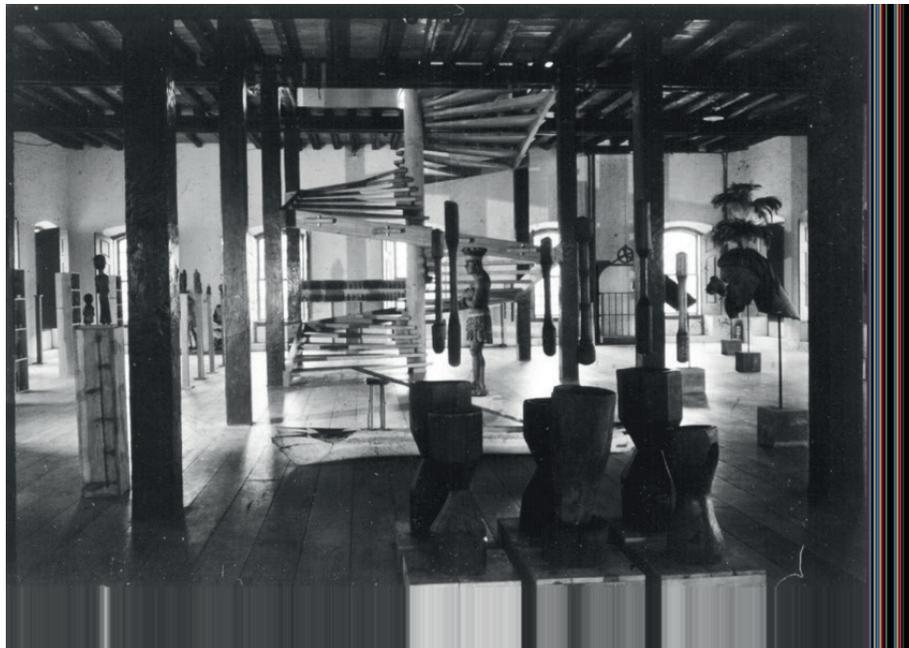
No casarão do Solar do Unhão, sede do novo MAP, foi onde Lina pôde dar sua contribuição arquitetônica mais relevante nesta intervenção: a instalação de uma escada de madeira, helicoidal, de planta quadrada (Lima, 2021), para a qual desenhou encaixes inspirados na canga dos carros de boi. Ao usar uma referência da cultura popular, Lina reforçou seu entendimento sobre essa produção enquanto saber genuíno e expressão cultural. O Solar do Unhão, já restaurado, foi
