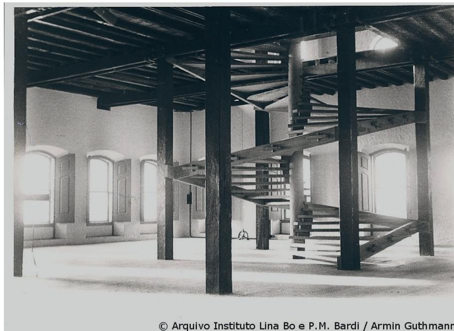
A escada, de planta quadrada, desenvolve-se em espiral em torno de um mastro central, sustentada por vigas conectadas a quatro colunas existentes no local, construída completamente em madeira e com fixação de encaixe entre as peças: “um símbolo da simplicidade camponesa do sertão nordestino e da Itália da infância de Lina” (Lima, 2021, p. 259).
