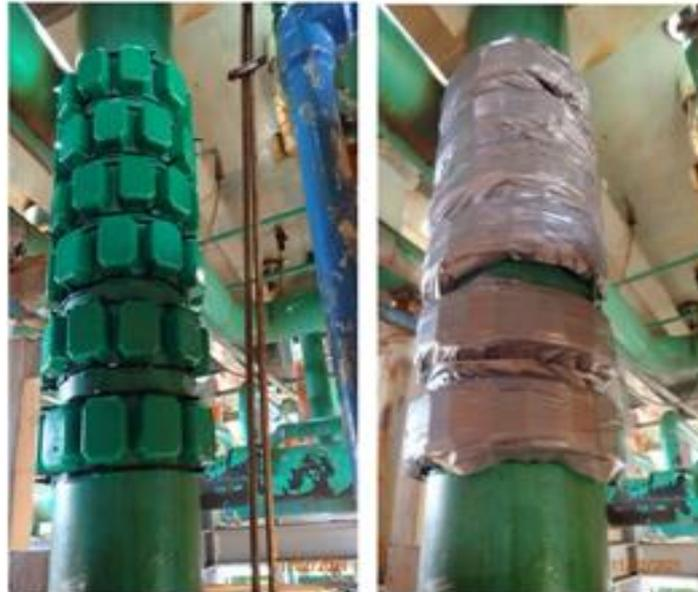
*Figura 5. Fotografias de imãs instalados ao redor de tubulação de água a montante dos trens de membranas em unidade de remoção de sulfato*
