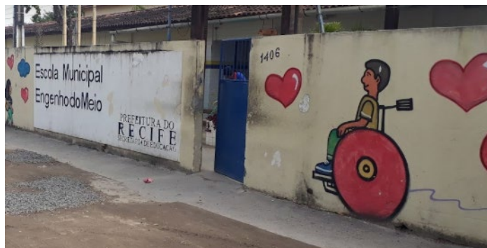
Figura 1. Fachada da Escola Municipal do Engenho do Meio Fonte: Google Maps.
