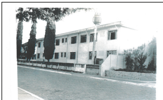
Prédio anexo Colégio- Residência das Irmãs
