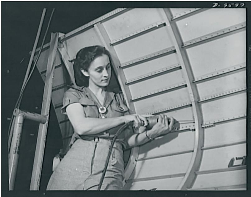
Figura 4: montagem de fuselagem de aeronave
