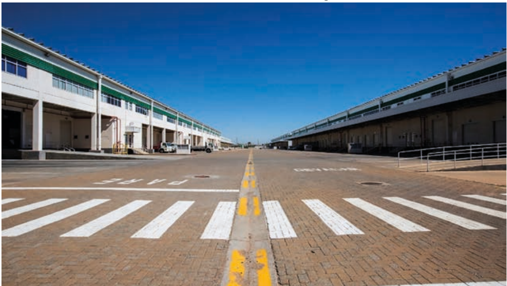
Foto 9 - Pátio Interno GLP Campinas
