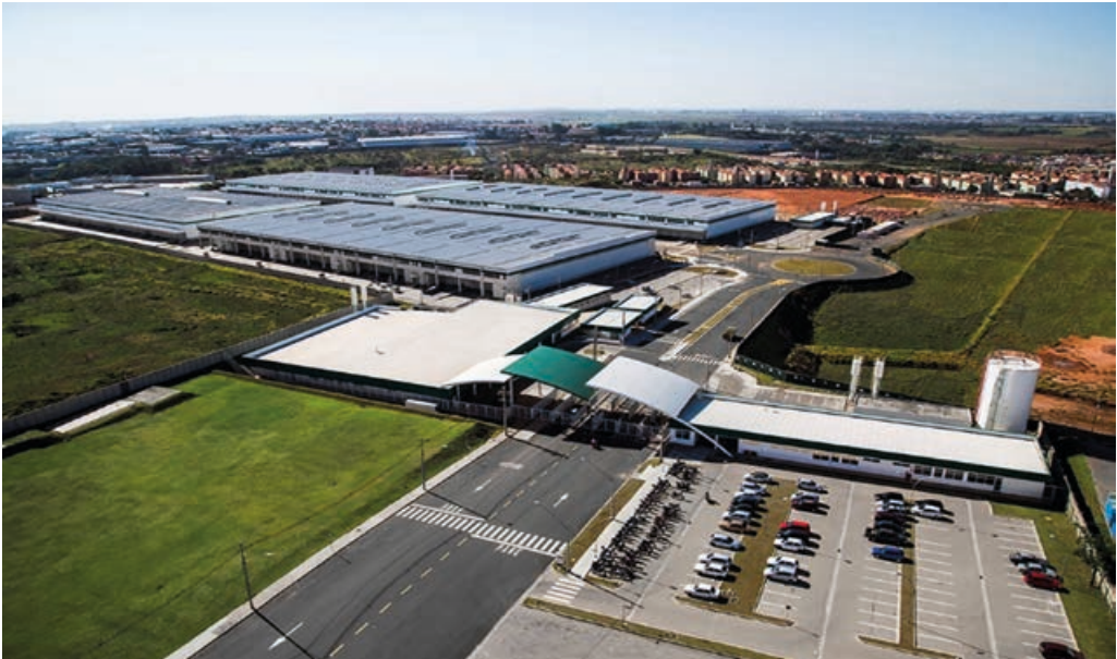
Foto 8 - Vista Área GLP Campinas
