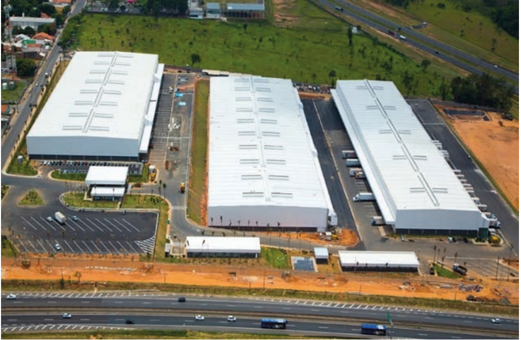
Foto 7 - Vista Aérea - LOG Hortolândia
