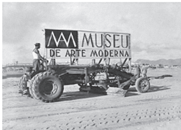
9 de dezembro de 1954. O presidente da República, João Café Filho crava a estaca fundamental da sede do Museu dando início simbólico à construção do bloco-escola.
