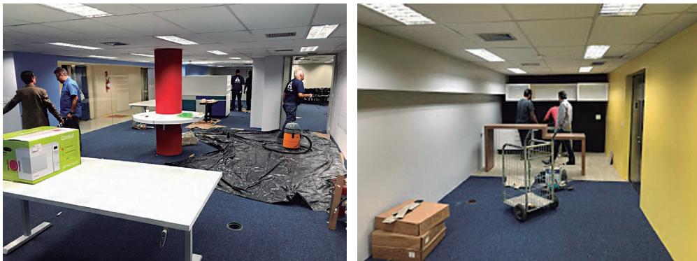
Figura 2. Fotos da reforma.
