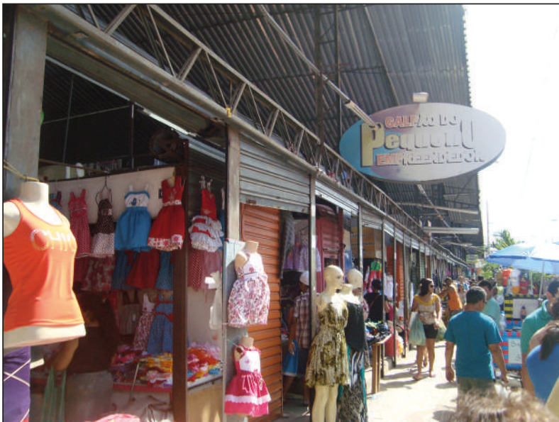
Figura 48 – Vista do empreendimento Galpão do Pequeno Empreendedor, na Rua José Avelino, em Fortaleza/CE.
