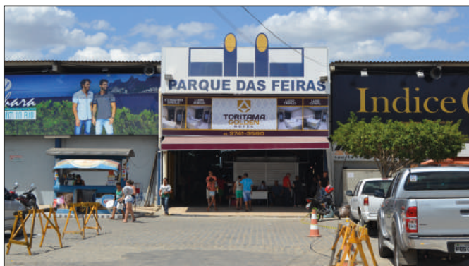
Figura 45 – Vista frontal do empreendimento Parque das Feiras, em Toritama/PE.
