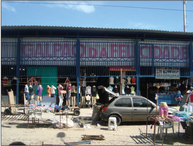
Figura 47 – Vista do empreendimento Galpão da Felicidade, na Rua José Avelino, em Fortaleza/CE.
