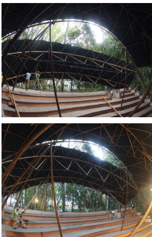
Figura 22: Procedimento de montagem da estrutura de cobertura do Anfiteatro, que apresenta a elevação do módulo de casca treliçada reforçada por arcos de flexão ativa. A estrutura é soerguida por elevadores móveis e alavancas em um sistema adaptável para o terreno em declive do Anfiteatro.
