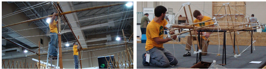
Figura 25: Mastros empregados na construção de um estande de exposição, empregando longarinas de 8m de comprimento e diâmetro das longarinas de 60 mm. Fonte: Bambutec, 2009.
