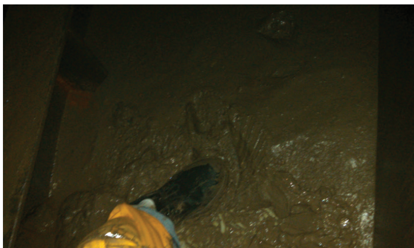
Figura 57 Presença de sedimento no fundo do tanque de água de lastro
