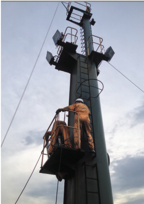
Figura 66 Instalação dos equipamentos no mastro do navio e passagem dos cabos para a parte interna do paiol do mestre
