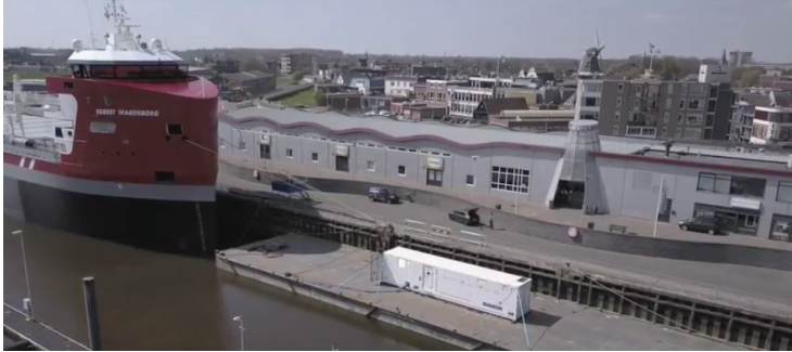
Figura 32 Sistema de tratamento móvel da Damen Invasave instalado sobre uma barcaça que permite mobilidade ao sistema de tratamento instalado dentro de um container 3
