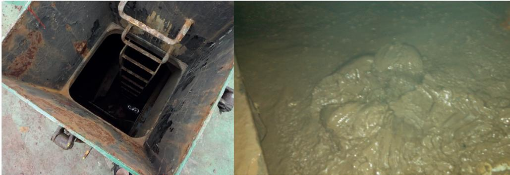
**Figura 6** Acúmulo de sedimentos no fundo e na parede dos tanques
