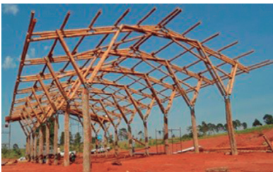
Figura 8 – Galpão em bambu do grupo Viverde. Fonte: Barata (2017).
