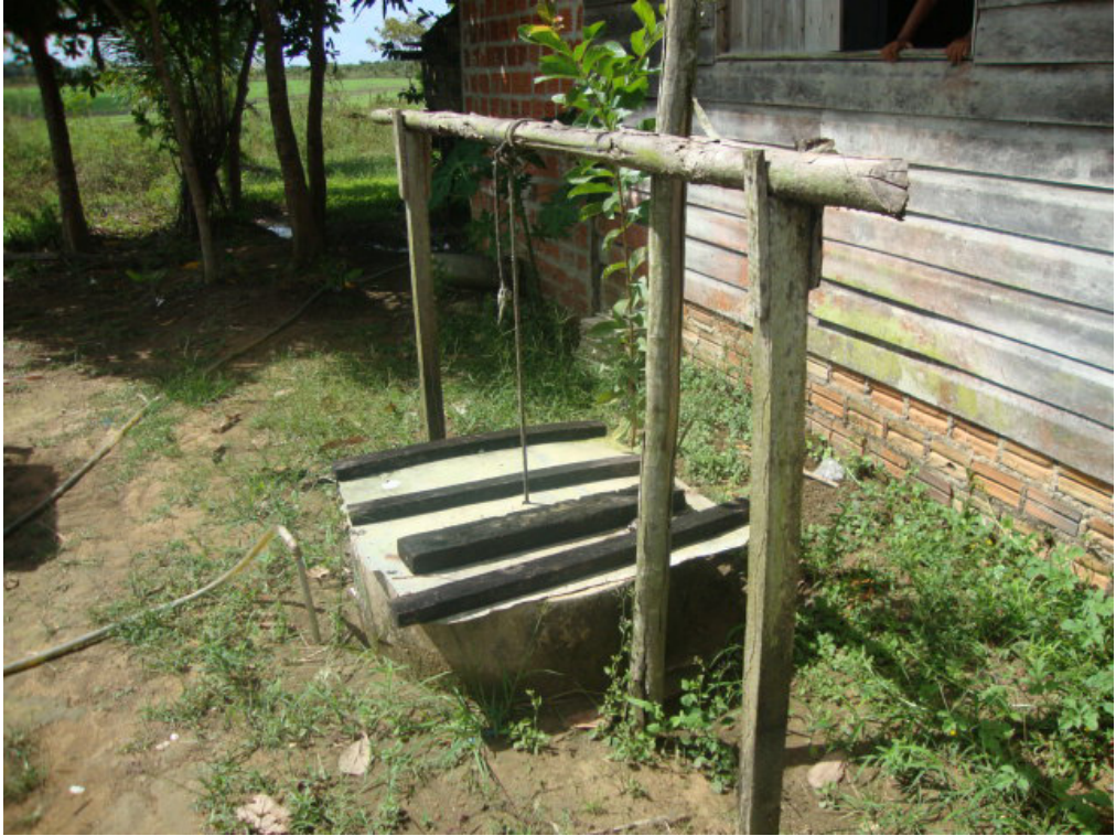
Figura 3.4 Poço amazonas em residência típica da Vila da Ressaca da Pedreira-AP. Fonte: Rosângela Silva (2010).
