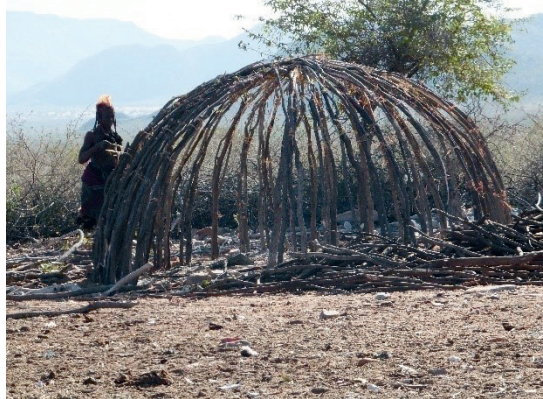
Figura 9.27 – Cubata em construção. Fonte: foto de Nazareno Campos.
