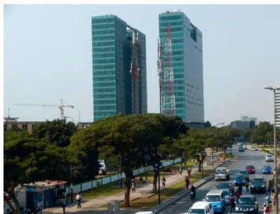
Figura 9.3 – Luanda atual: muitos prédios em construção. Fonte: foto de Nazareno Campos.
