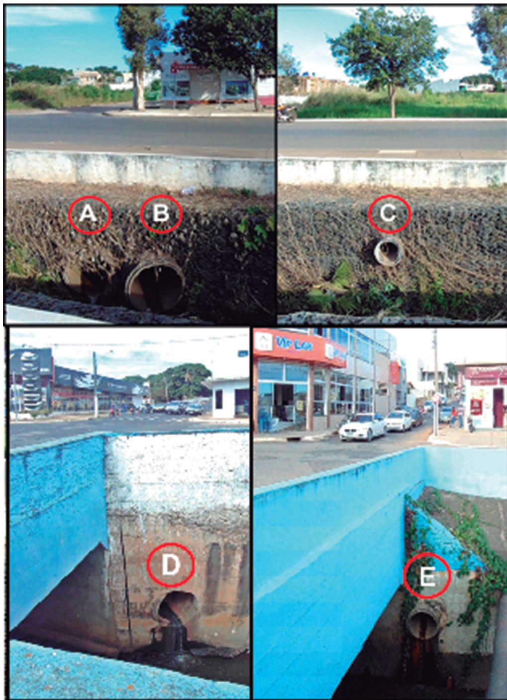
Figura 3. Pontos de coleta (manilhas) da água pluvial ao longo do Ribeirão Pirapitinga, Catalão. Março/abril de 2015.
