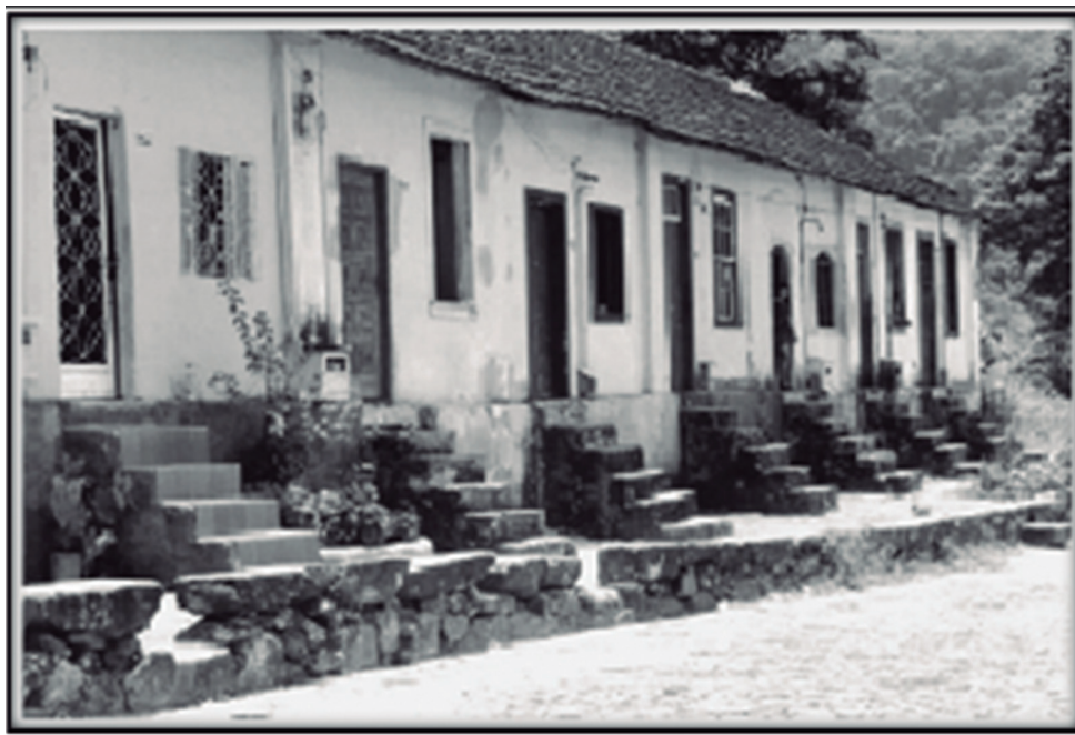
Figura 1. Vila operária erguida pela Companhia de Fiação Cometa, Petrópolis-RJ. Fonte: Correia (2006).
