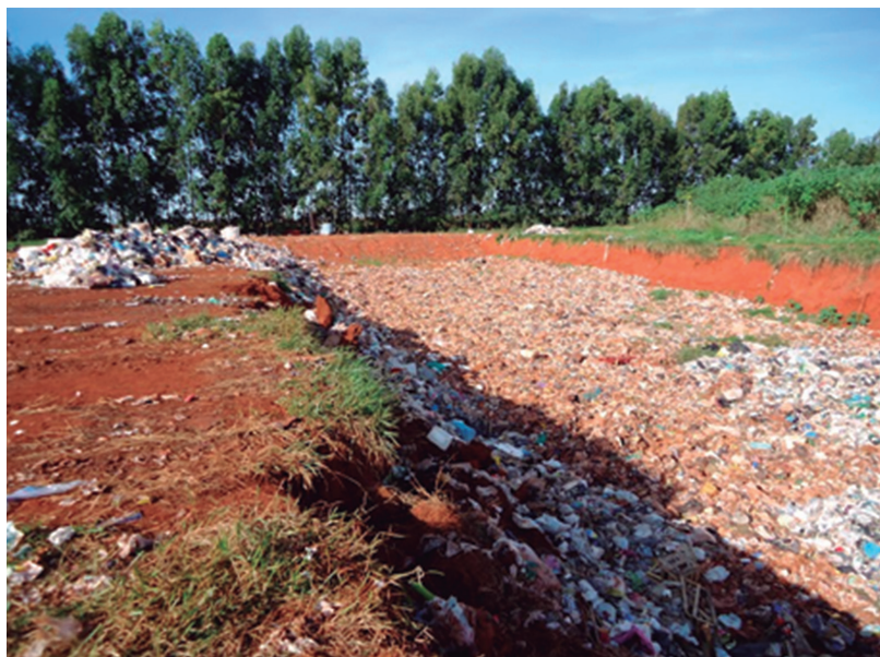
Figura 1. Aterro municipal de Goiandira: valas abertas sem atender a normas e legislações (2015). Crédito: Mayara Cristina Tristão.
