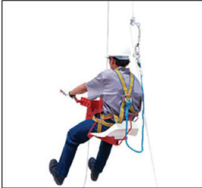
Figura 9 – Exemplo de trabalho em altura executado em cadeira suspensa, de acordo com a NR 35. Fonte: Engenhall Cursos NR 35 (2015).
