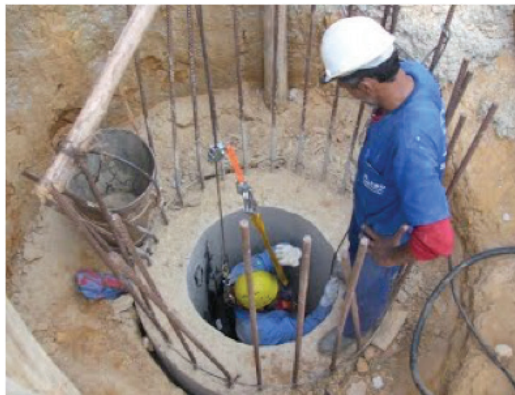
Figura 8 – Trabalho em espaço confinado: execução de fundação do tipo tubulão de ar comprimido. Fonte: Naresi, 2010.
