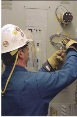
Figura 3 – Exemplo de medida de segurança em instalações e serviços de eletricidade. Profissional deve utilizar os EPIs adequados para a função. Fonte: Comseg (2015).
