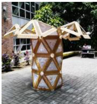
Fig. 19. Instalación “Biogénesis 2018”. Consta de una estructura geodésica de madera contra- chapada flexibilizada por corte láser y una piel de poliestireno deformado por calor y gravedad. Diseño de la LIME. Fotografías de Ever Patiño.
