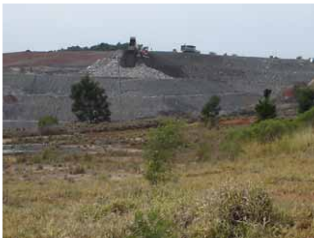
Figura 4.1 Descarga do material usado no recobrimento da massa de resíduos.
