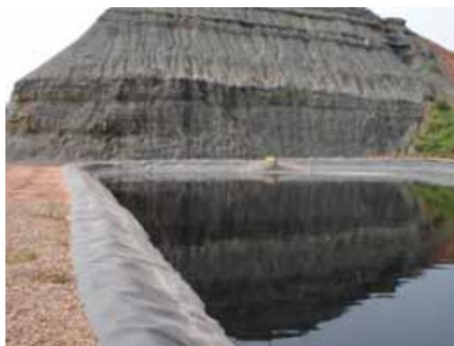
Figura 4.9 Tanque a partir do qual era bombeado o lixiviado até o divisor de águas do aterro.
